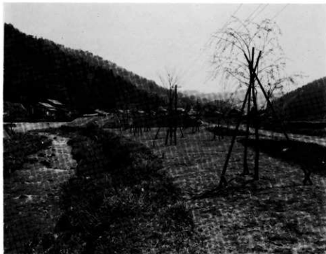
公園センター予定地北側整備状況 北から
