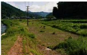
挿図5 調査前遠景2（北から）
