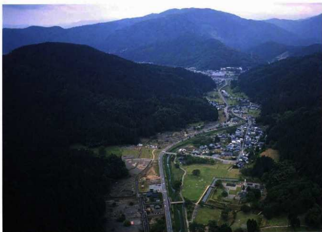
(2) 同遠景(南から)
