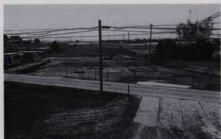
F区全景（東から）
