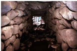
千人塚古墳の横穴式石室（入口側） / 平成14年度調査
