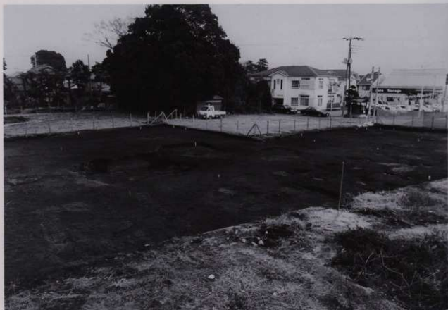
1 第5次調査表土探削後の状況
