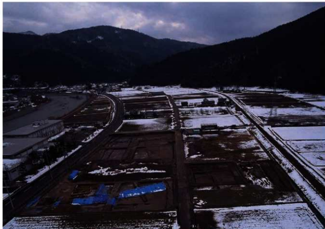
(1) 調査区全景(北方上空より)
