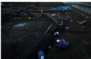
東区南平S07027埋土掘削作業(南より)
