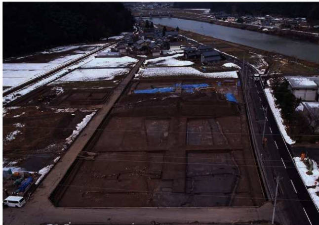
(1) 東区南半全景(南方上空より)
