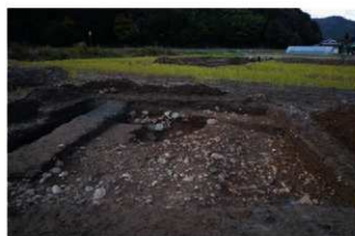
(7) 試掘トレンチT11全景(南東より)
