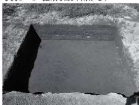
写真3-3 掘削状況（南から）
