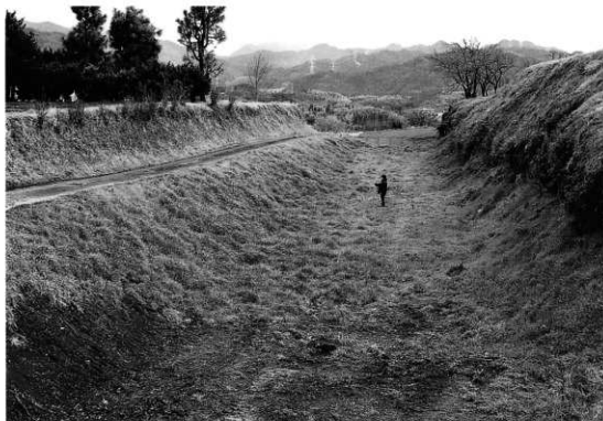
図版 22 大空堀（東側）D2からD3を見る
