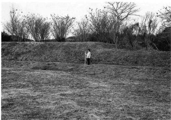
図版15 大土塁「上げ土」 A区からB4・B5を見る
