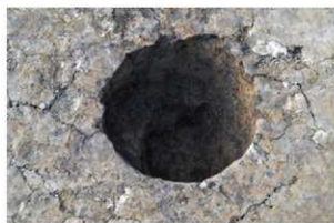
4 第2号ピット完掘 (南から)
