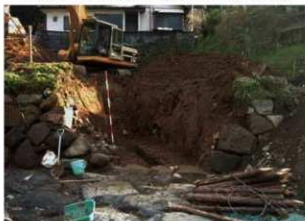
石積裏確認トレンチ掘削状況 北から
