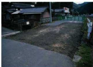
往還眼鏡橋 掘削前 南西から
