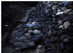
Ⅹ区 東側石積前基礎固め状況 東から
