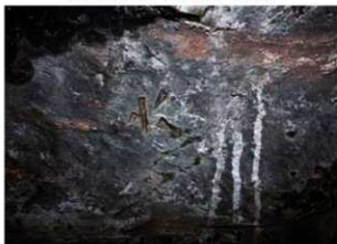
築の樋門 天井部分 “六”が刻まれる
