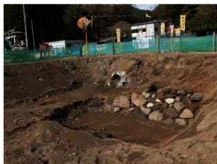
樋管工事部分出土状況 南東から
