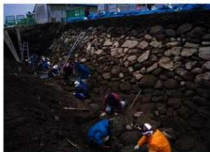
石積検出作業状況
