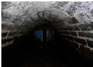
築の樋門 天井部分
