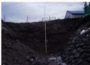
Ⅷ区 堆積状況 東から
