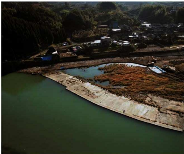
鶺ノ瀬堰調査時 遠景 北から
