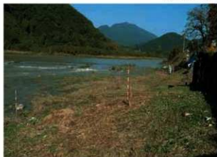
鶺ノ瀬堰調査前下流側 西から
