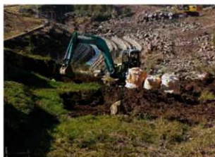
調査状況 表土剥ぎ
