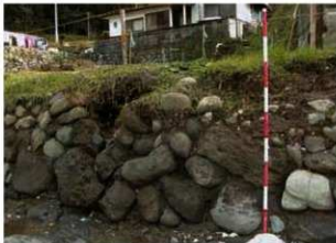
石積出土状況⑥ 北西から
