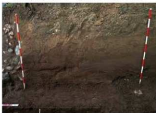
石積裏確認トレンチ 土層断面状況 西から
