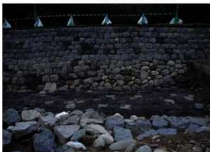
I区 東側石積立面 南から
