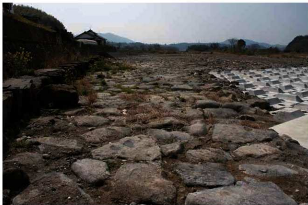
現在の鞆ノ瀬堰の石畳(左岸：東寒野側) 東から
