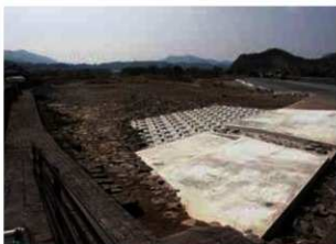
平成24年 現在の鶺ノ瀬堰 流された石畳部分はコンクリートで修復された
