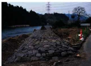
Ⅶ区 刳除草後 北東から
