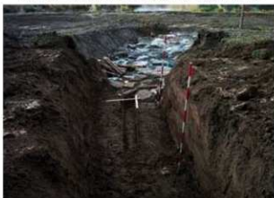
石積裏確認トレンチ掘削状況 南から
