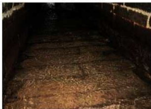
築の樋門 石畳部分
