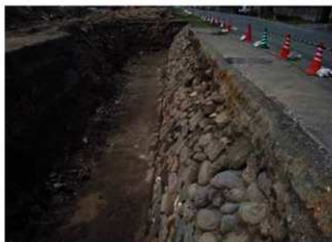
VII区 石積出土状況 東から
