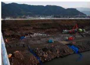
安津橋根元(右岸) 災害復旧工事箇所
