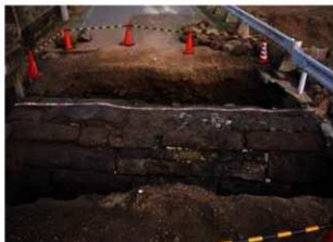
往還眼鏡橋 掘削状況 西から
