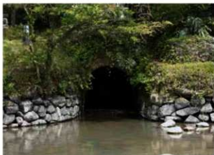
鶴ノ瀬堰下流 築の樋門 西から
