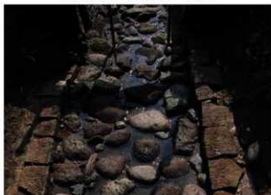
往還眼鏡橋 橋除去後石畳出土状況 北から
