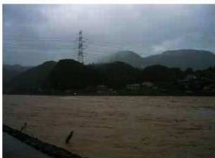
平成19年7月 被災中の鶺ノ瀬堰 右岸から洪水が鶺ノ瀬堰を襲う 堰体の場所が白く波立つ
