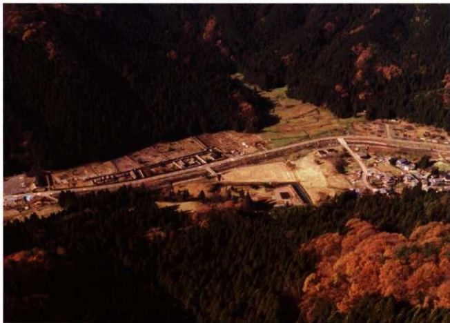
(2)第102・104次調査区遠景(南東から)
