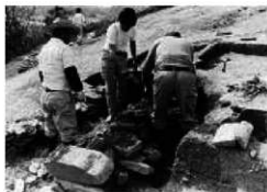
5. 2号墳石室解体作業風景
