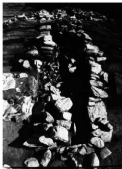
1. 1号墳石室崩壊状態（北西より） 東側壁の崩壊が顕著。 一方向から重力が石室を崩壊へ至らしめた事がわかる。
