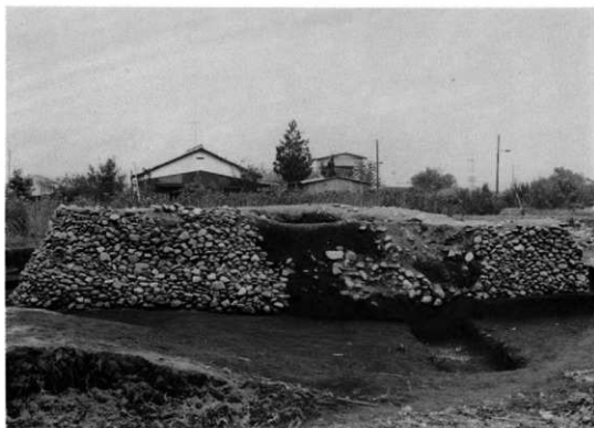
2. 長沖21号墳控え積み（西より）
