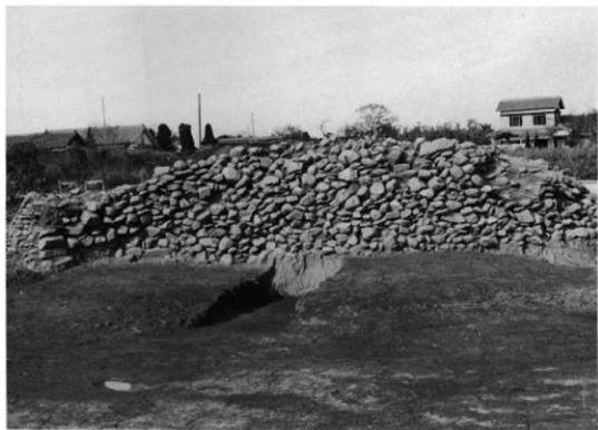
2. 長沖8号墳控之積み(東より)
