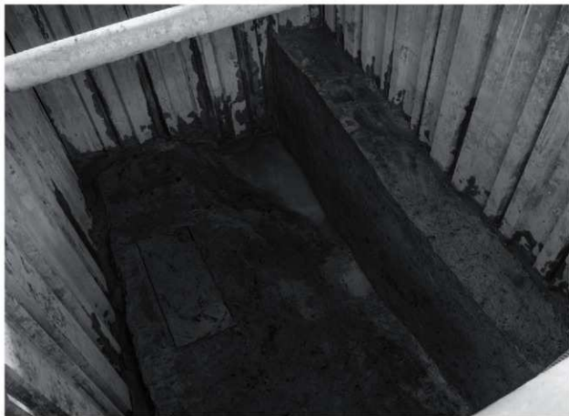
9-2 トレンチ 全景・土層断面 【北から】
