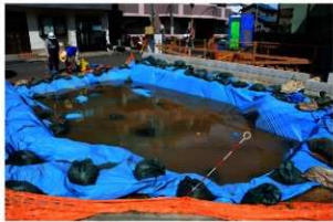
8 2区冠水状況 (南西から)
