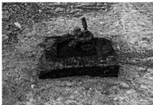
5. 15号遺構下段消火栓検出状況（南から）
