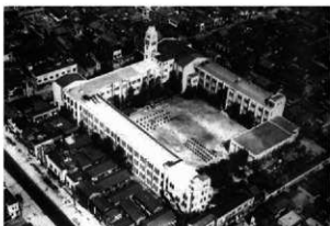
昭和10年頃(昭和3年竣工の復興建築コンクリート校舎)
