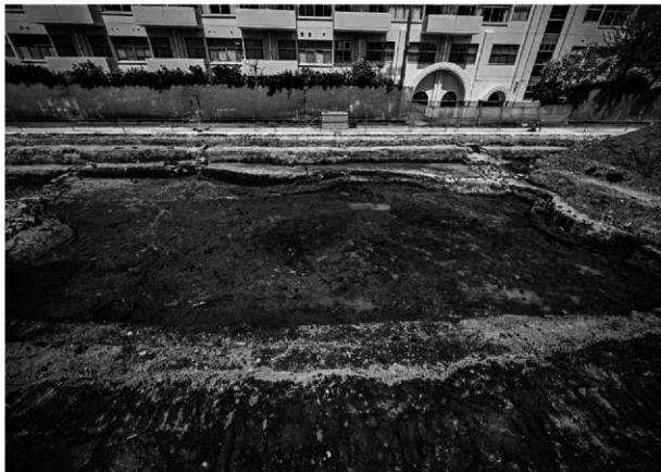
2. 池遺構完掘（南から）
