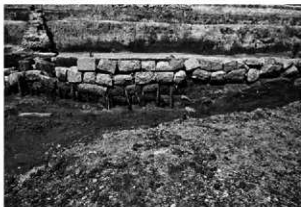
8. 61号遺構 (F) 石積前面 (南西から)
