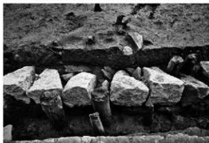
3. 33号遺構石積近影（I区）（2）（北から）
