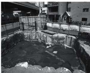
fig.129 III区第1遺構面全景(西から)
