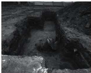
fig.183 1 トレンチ全景 (東から)
