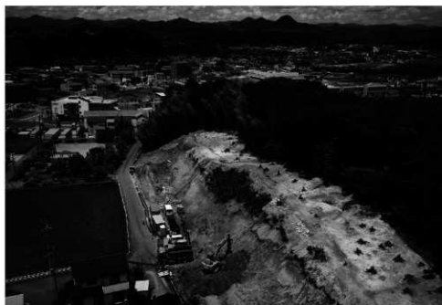
fig.203 調査地全景 (南西より)
