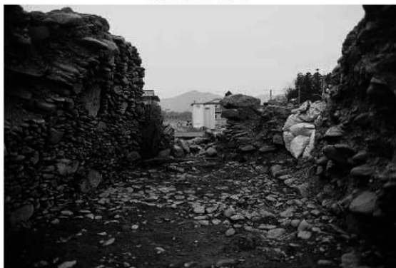
東側壁（北から）
