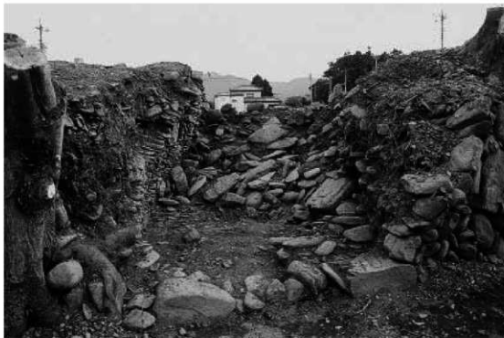
西側壁崩落状況（北から）
