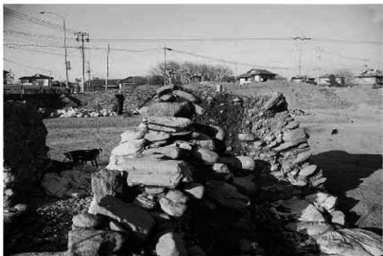
東側壁裏側の状況1（南から）
