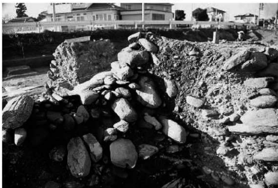
東側壁裏側の状況2（南東から）
