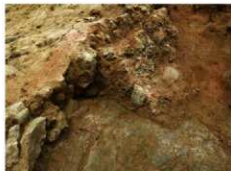
当初窯西側壁 礎での補修を想定
