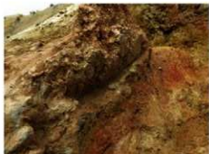
最終窯西側壁 立ち上がりの状況
