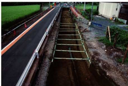
1 東側調査区全景 (1) (南より)
