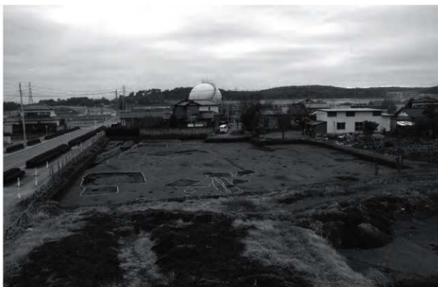
D地点調査区全景（北より）
