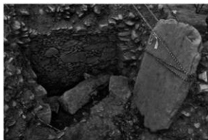
石室天井石陥没状態
