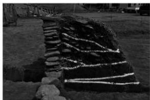
西側第1葺石裏込め
