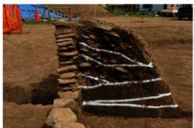
西側第1葺石裏込め
