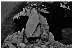
羨道部天井石架設状態
