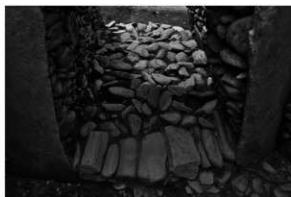
羨道部床面（玄室側から）
