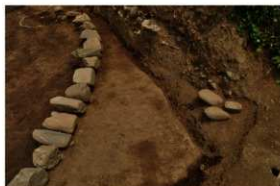
南東側第1・第2葺石根石
