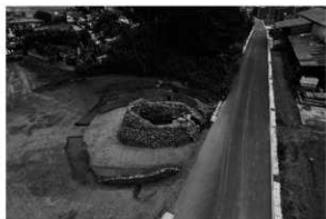
葺石・石室全景（西より）
