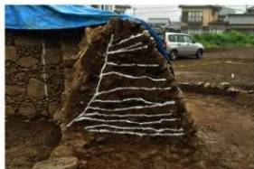
玄室東側側壁裏込め土層堆積状態
