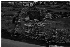
石室全景（閉塞状態）
