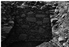
玄室奥壁（棺床面除去後）
