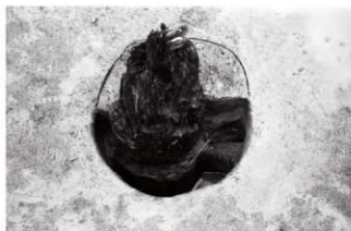
(4)SB28[SP594]柱根(東より)
