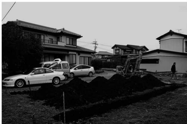
平成21年度 左口遺跡日地点 試掘調査風景写真(南西から)
