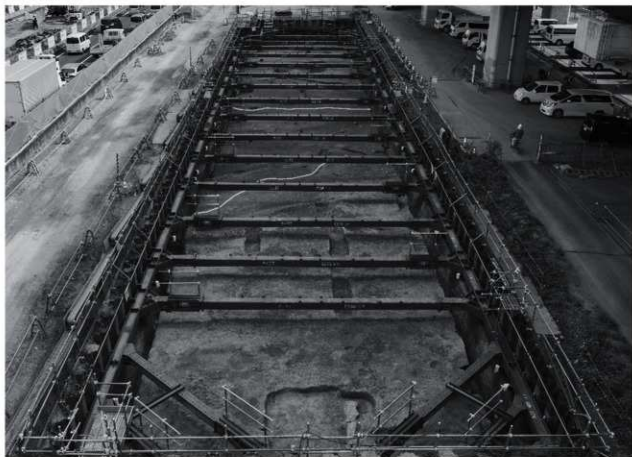
1. 3区 第3b面全景（北から）
