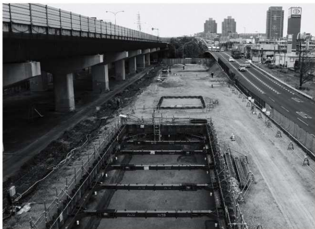
2. 調査区遠景（2区南から1・2区をのぞむ）[右が主要地方道大坂中央環状線で、支柱を建て、この上に大坂モノレール軌道を建設予定]
