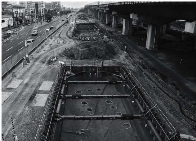
1. 調査区遠景（2区北から2・3区をのぞむ）[右が近畿自動車道天理～吹田線]
