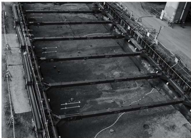
2. 3区 240 流路（北東から）
