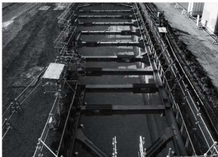
1. 5区 第3b面全景（北から）
