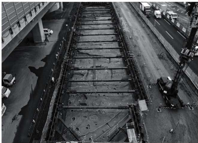
2. 3区 第3面全景（南から）
