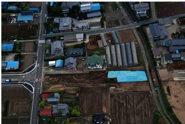
1 調査区北東側遠景
