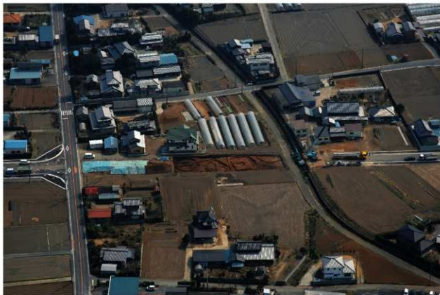
2 調査区南西側遠景
