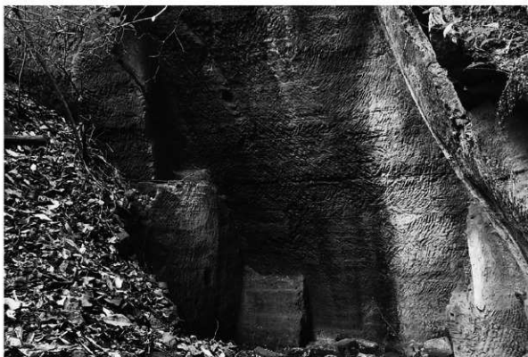
写真6 久利町赤波に残る採石跡
