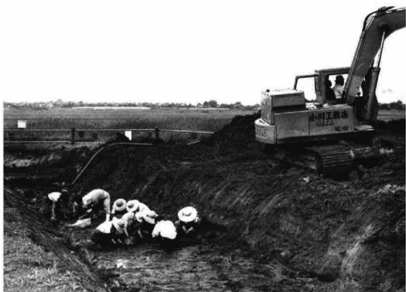
(1) 調査作業風景
