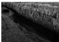
図48 たわみ部の土層
