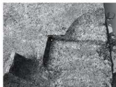
完壁状況 (南より)
