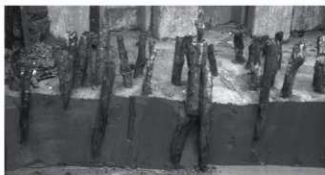
④南群 (b-b') 打ち込み状況
