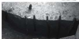
③中央群 (a-a') 打ち込み状況
