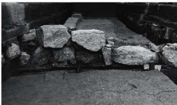
e. 西端石垣立面 (北から)
