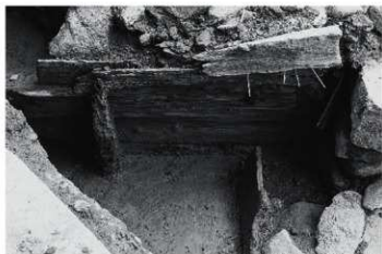
b. 上流側樋門南側護岸 (北から)
