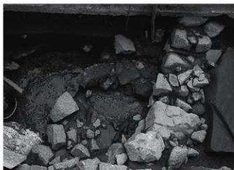
b. 東端水路 (西から)
