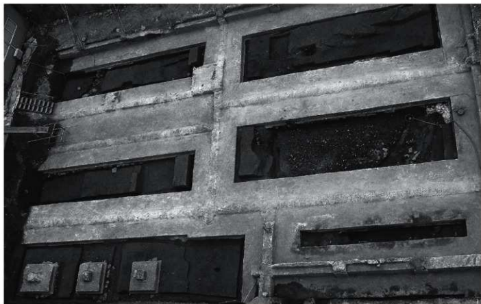
a. 前期調査 (西から)
