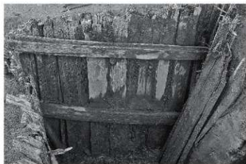
2. 南側板 (北から)
