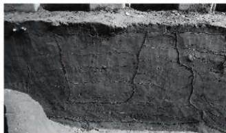
2. 土坑17断面 (南より)
