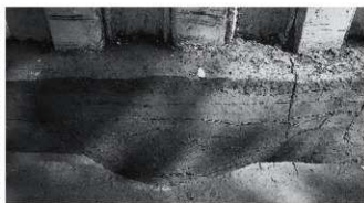
6. 土坑20断面 (南より)
