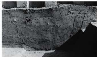
3. 土坑18断面 (南より)
