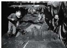
図4 調査風景(上：A地点、下：C地点)
