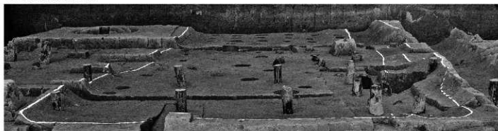
2. 完掘状況（南から）
