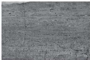
4. 畦畔1断面 (北から)
