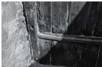
5. 井戸3井戸枠 (北辺) 角柱・桟木組合せ状況 (南から)
