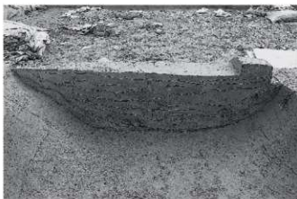
1. 溝11 (古段階) 断面 (北から)
