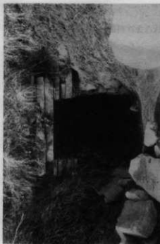
6. 石室南壁部(開口)
