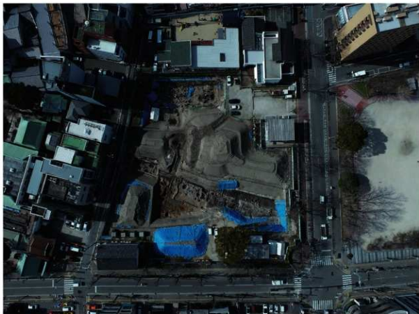
第211次調査地点(上空 北東より)
