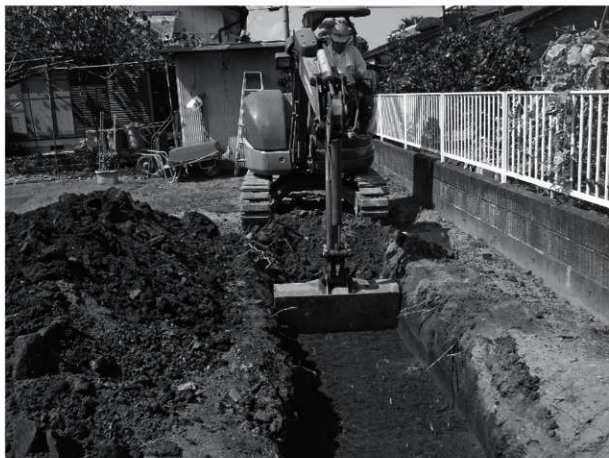
女池遺跡E地点 試掘調査風景
