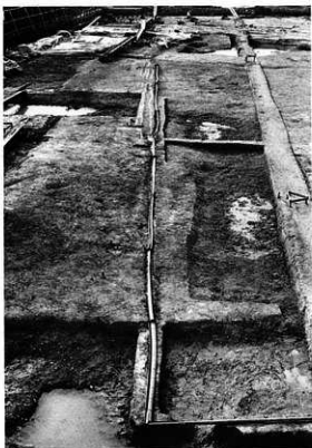
ⅢW区 樋4 (東から)
