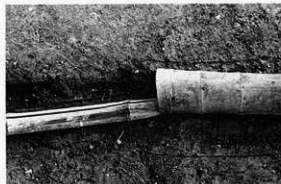
樋4と土管接合部
