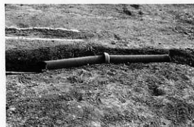
樋4 先端の土管
