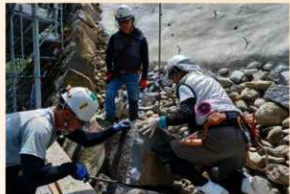
微調整を繰り返して石を積み直す様子
