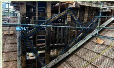
土壁の解体で見えてきた鉄骨の筋かき
