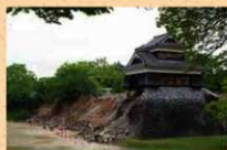
被災直後の戎亥櫓と崩落した石垣
