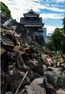
6 崩落した奉行丸西側の石垣
