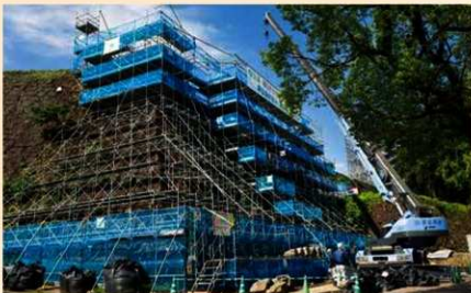
平櫓下石垣の積み直し工事
