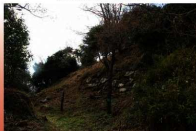
伝本丸北面の食い違い虎口と石垣
