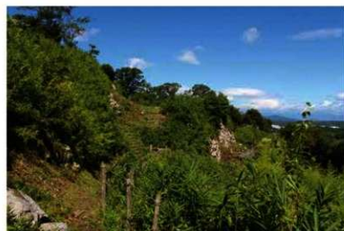
伝本丸北面の2段の石垣
