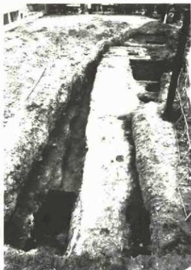
◀1. 第II次調査区 土丹敷遺構（東から）
