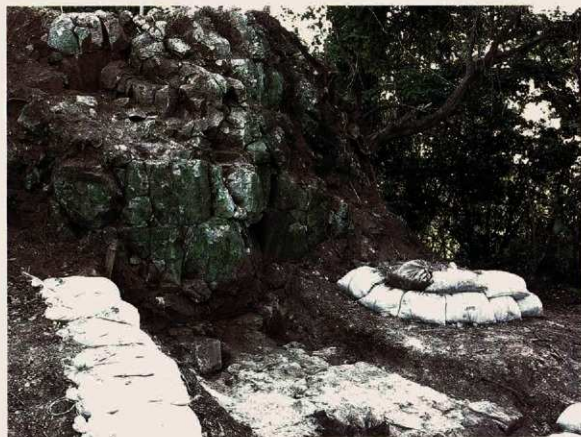
写真92 第1号トレンチ下段平場(北東から)
