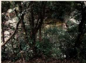
写真113 「大堀切」現況(南西から)
