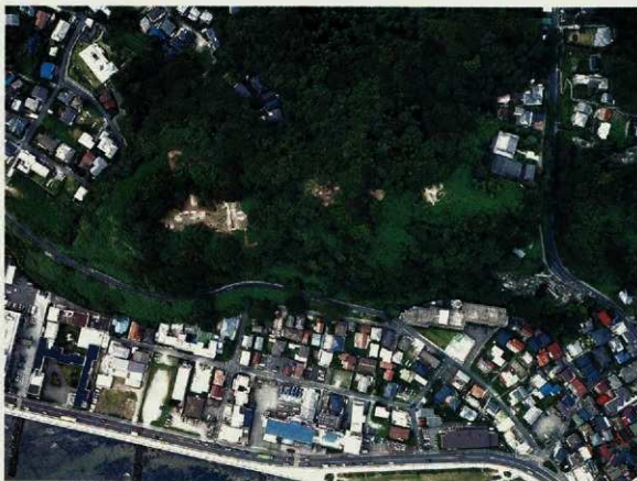
写真71 第26、27、33号トレンチ付近空撮
