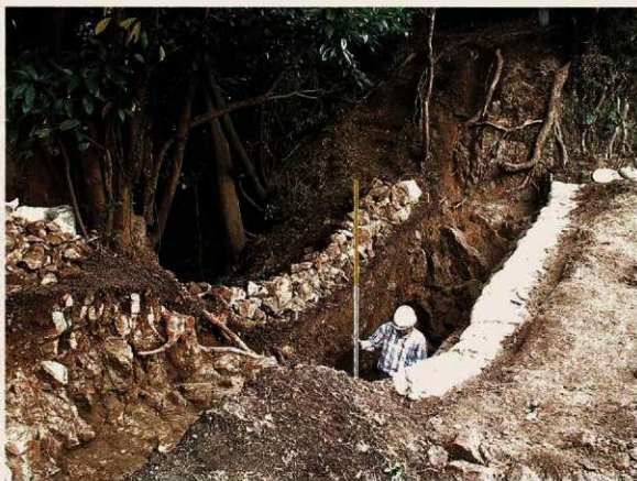
写真210 第4号トレンチ 全景(東から)
