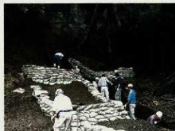
写真162 第13号トレンチ 作業風景
