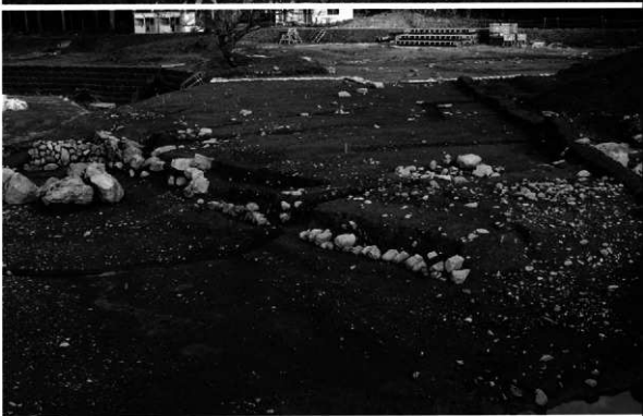
B1区南西部全景 (南西より)
