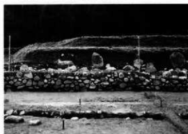
挿図12 土塼基礎石垣SA3184 (東から)
