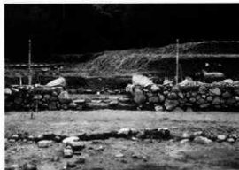
挿図11 土塼基礎石垣SA3184 (東から)
